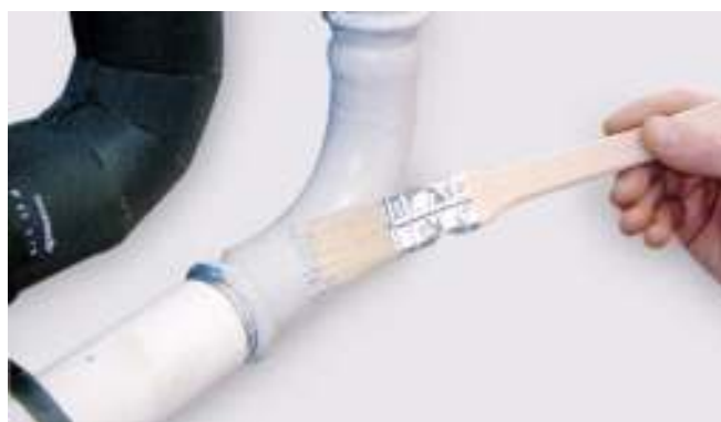
Рис. 37. Покраска соединений и труб праймером.
